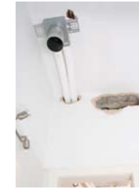
Luftdurchlass innerhalb der später abgehängten Decke
