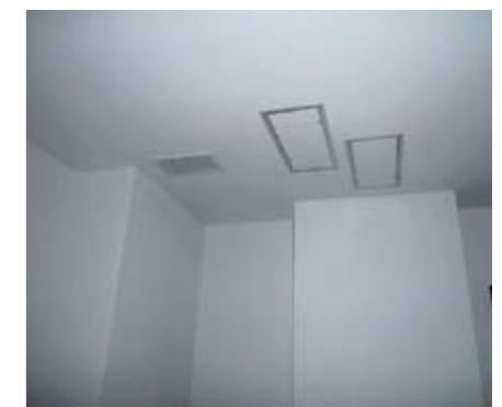
Eingebaute Revisionsdeckel
